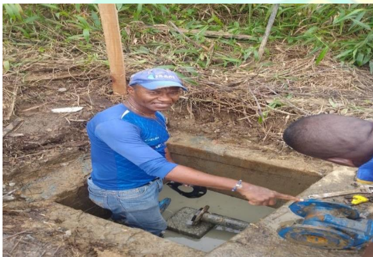
Ilustración 7 Mantenimiento de válvulas de compuerta brida
