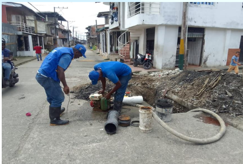
Ilustración 8 Excavación manejo de herramientas
