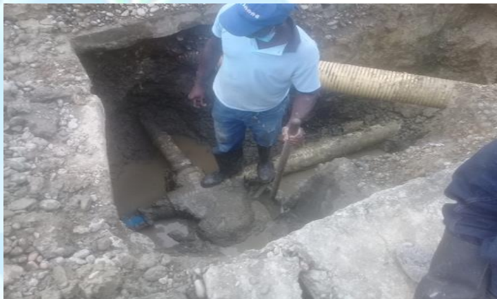
Ilustración 9 Reparación de obstrucción T empalme
