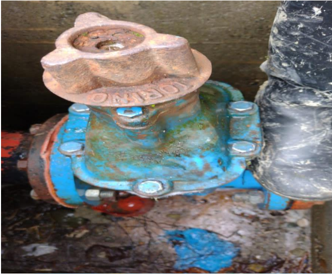
Ilustración 1 3 Mantenimiento de válvula de compuerta brida
