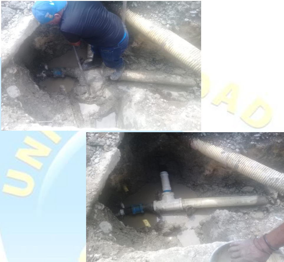
Ilustración 11 Cambio de te PVC presión lisa de 4" a 2"
