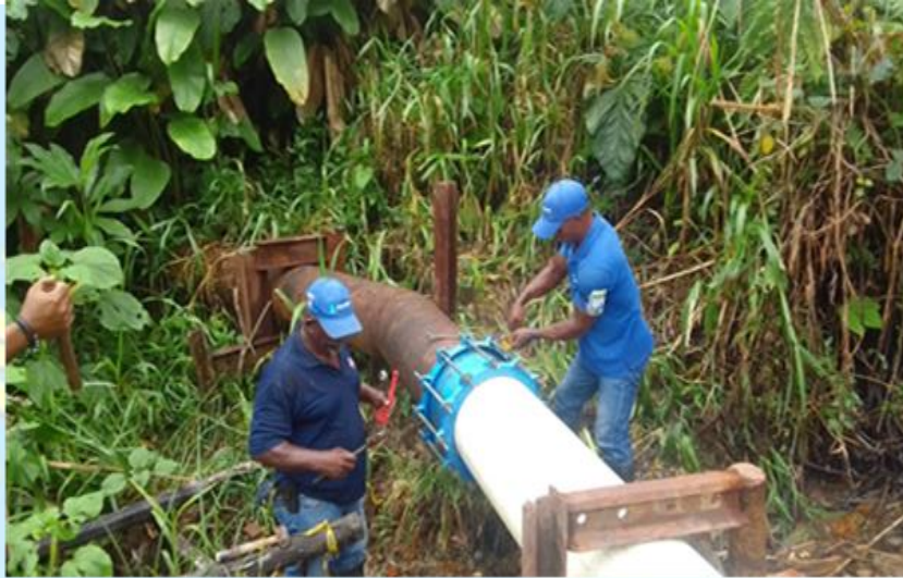
Ilustración 6 Reparación Tramo de tubería
