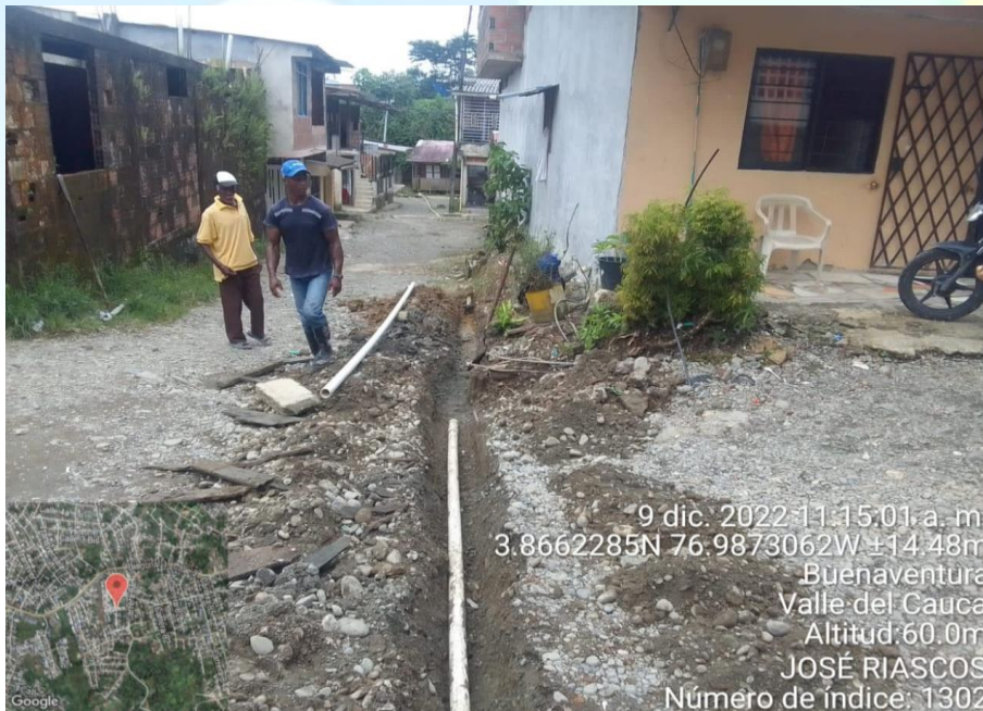
Ilustración 1 4 Actividad de excavación y reposición de red matriz 2
