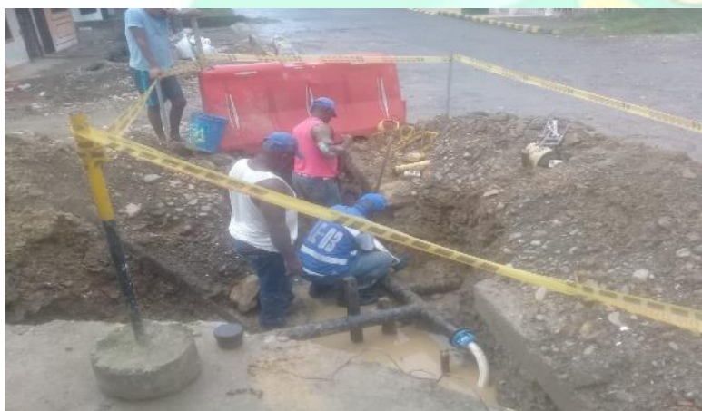
Ilustración 4 Cuadrilla actividad de empalme de reposición de redes
