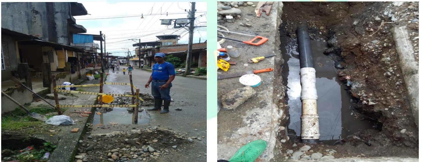
Ilustración 12 Mantenimiento de red e instalación unión UP 3.
