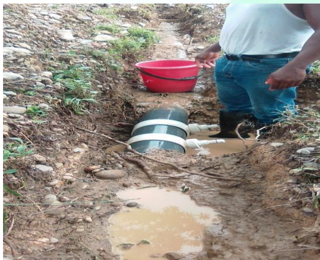
Ilustración 10 Instalación de Collarines
