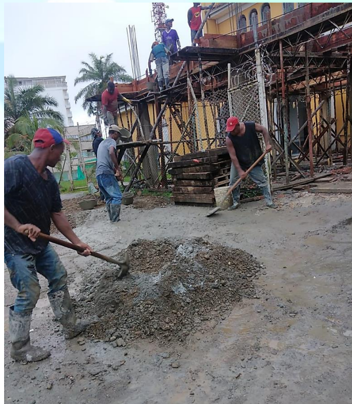
Ilustraciones 11. Fundición de vigas aéreas
