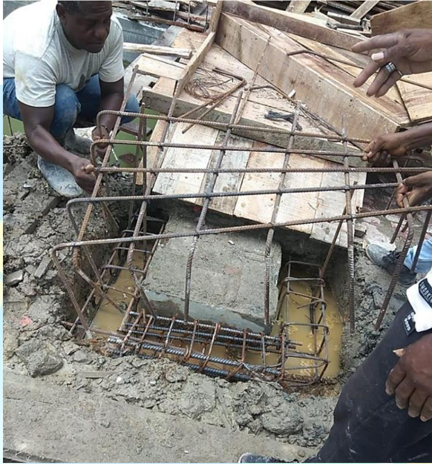
Anexos. 19. Armado de acero para escalera
