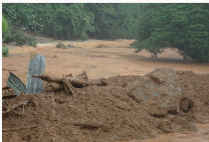
Amenaza y vulnerabilidad crean riesgo permanente en la carretera al mar.
