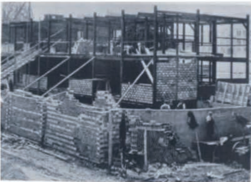
Figura 26. Esqueleto con cerramiento en ladrillo
