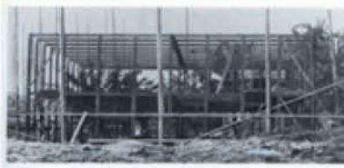
Figura 13. Esqueleto metálico con bloques de corcho
