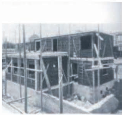
Figura 19. Esqueleto con bloques y paneles
