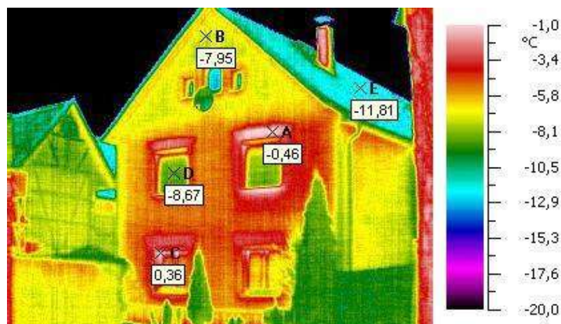
Ilustración 67: fotografía térmica de una vivienda. Fuente: ing. Ramón Dávila.
