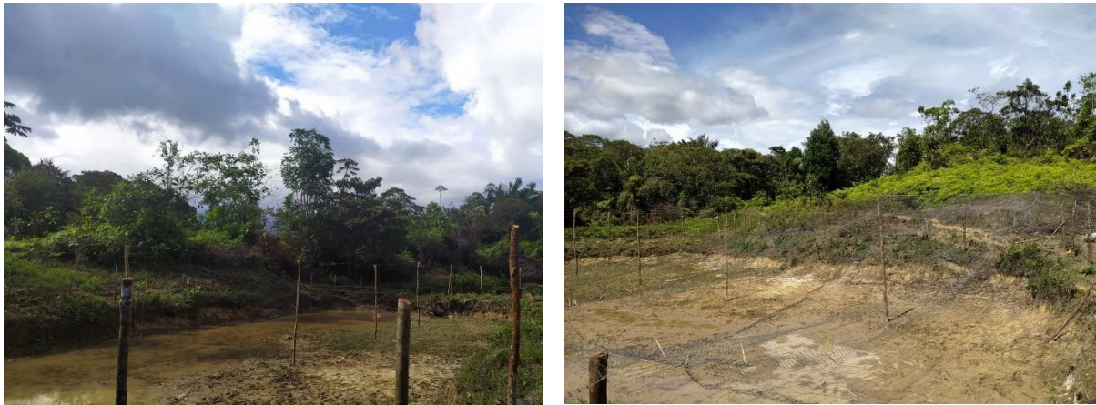
Figura 3 Instalación de mallas anti pájaros
