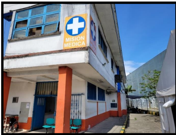
Figura 6-17: Ingreso principal Hospital Luis Ablanque de la Plata.
