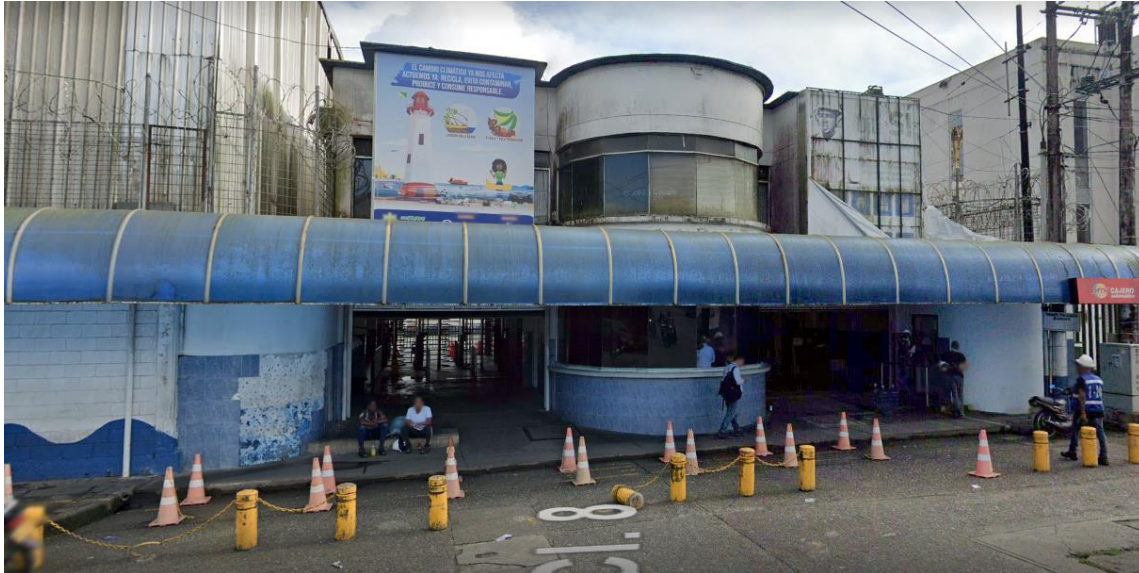
Figura 2. Puerta Raymond de SPRBUN S.A.
