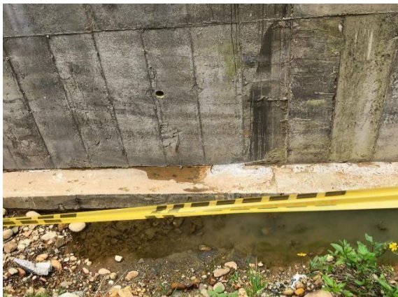
Ilustración 2. muro de contención
