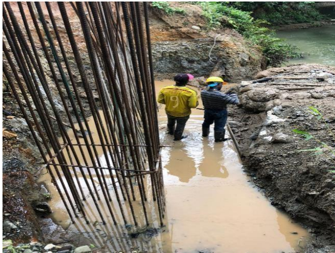
Ilustración 17. Limpieza de zarpa
