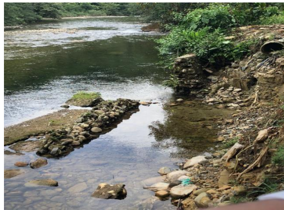
Ilustración 1. Ubicación de muro de contención
