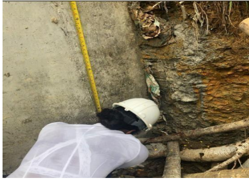
Ilustración 10 toma de medidas en el muro de contención
