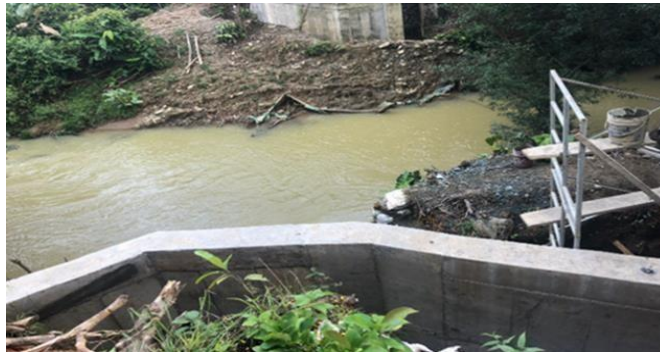
Ilustración 13 muro de contención venado 1
