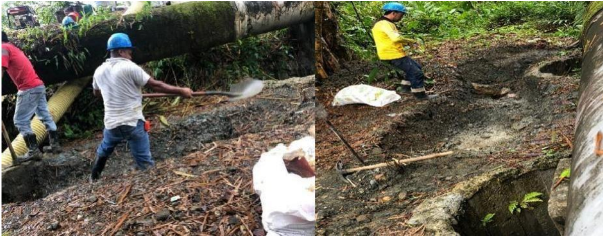
Ilustración 15. excavación para amarre de zapata.
