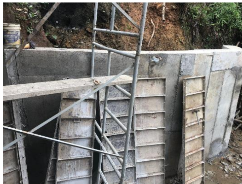
11. Desencofre de muro de contención
