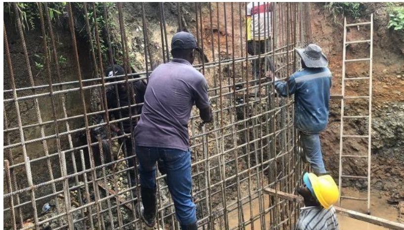
Ilustración 22 amarre de varillas para muro de contención con alambre
