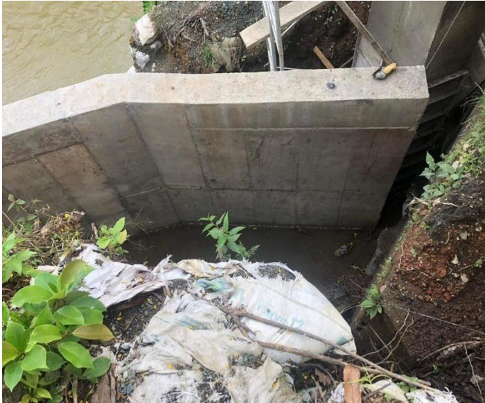
ANEXO 1. Muro de contención venado 1
