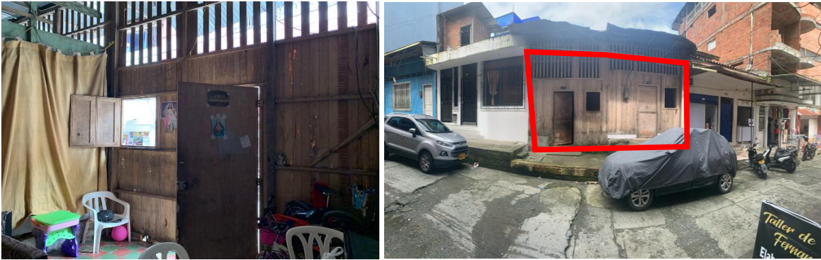
Fachada en madera
