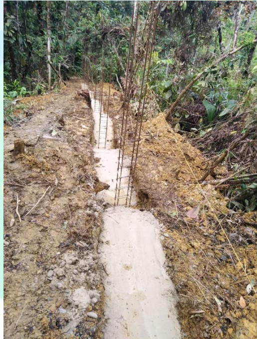
Anexo g. Solado de limpieza para vigas de cimentación
