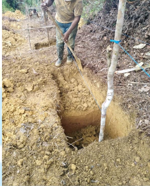
Anexo e. Excavación de vigas de cimentación
