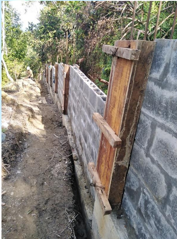
Ilustración 11. Encofrado y fundición de columnas
