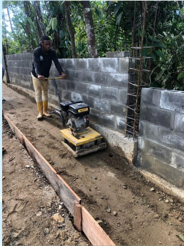
Ilustración 12. Compactación de material seleccionado con rana vibrocompactadora
