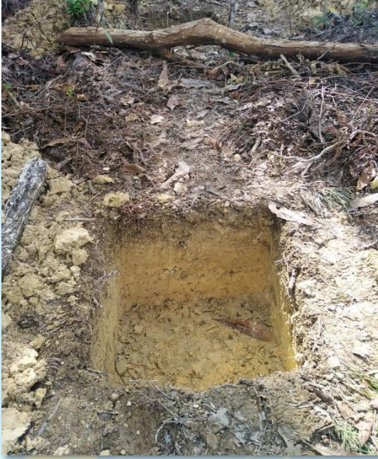
Anexo d. Excavación de zapatas
