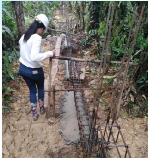
Imagen del armado de acero para vigas de cimentación – Fuente: Propia
