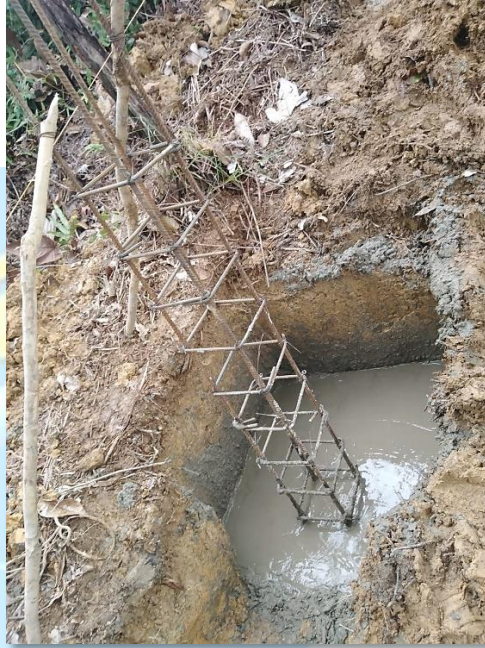
Imagen de la fundición de zapatas – Fuente: Propia
