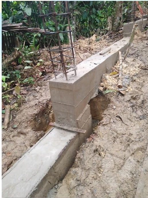
Imagen de la vigas y pedestales fundidos – Fuente: Propia
