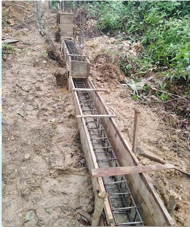
Ilustración 3. Construcción de muro perimetral
