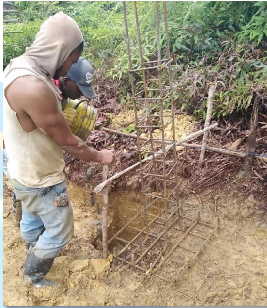
Imagen del armado de acero para zapatas de cimentación – Fuente: Propia
