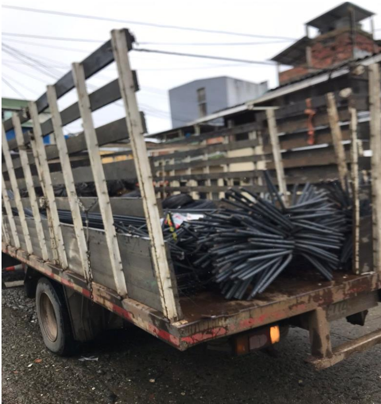
Ilustración 6. Verificación de acero estructural.
