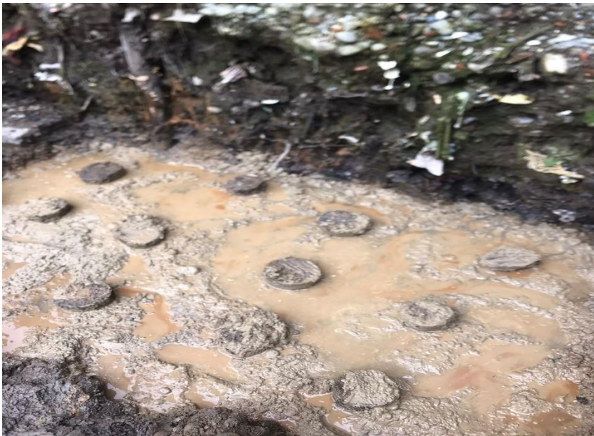
Ilustración 4. Solado de limpieza.
