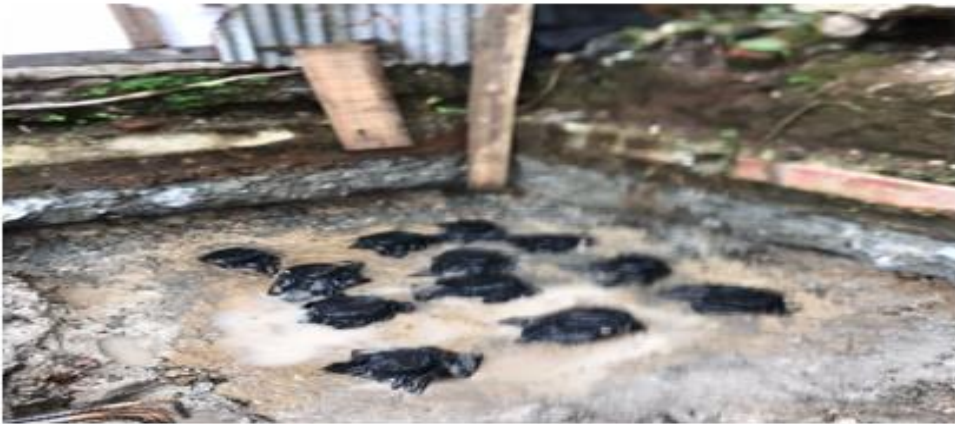
Ilustración 5. Protección para las cabezas de los pilotes.
