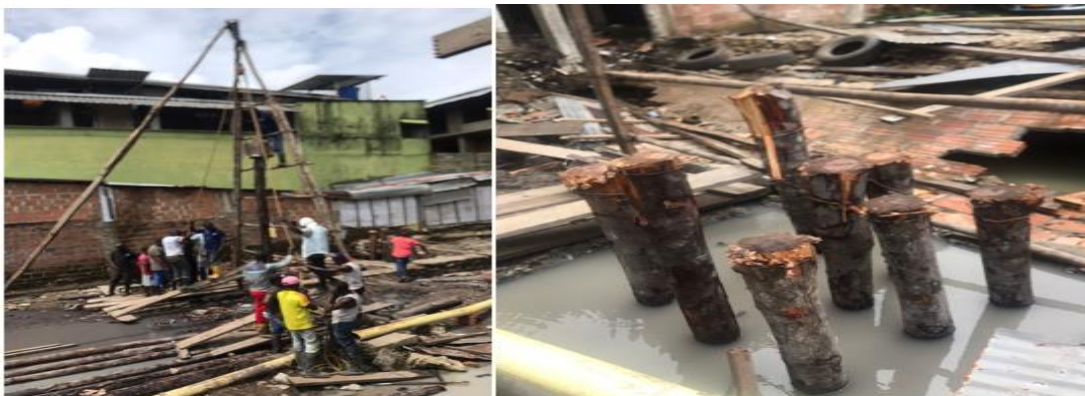
Ilustración 3. Hincada de pilotes en madera
