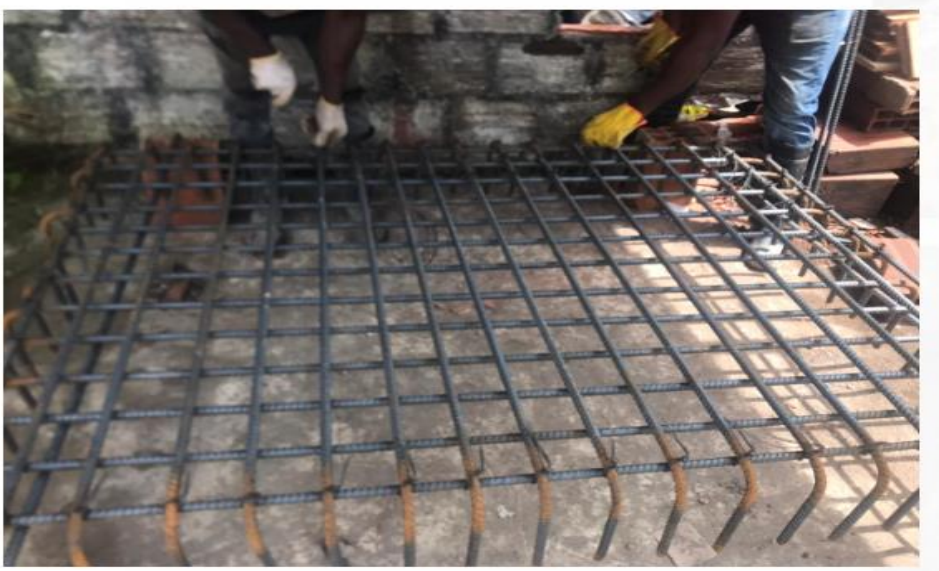
Ilustración 7. Armado de acero para las zapatas.
