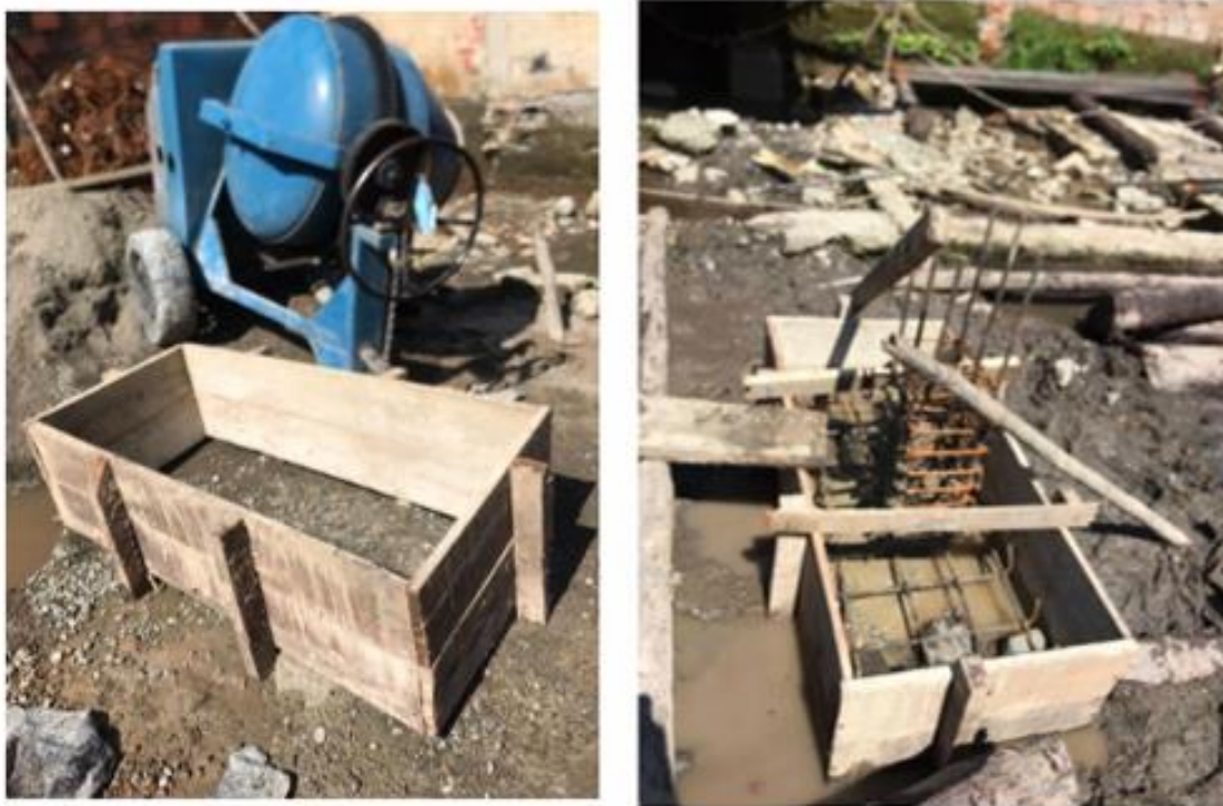
Ilustración 8. Formaletas en madera.
