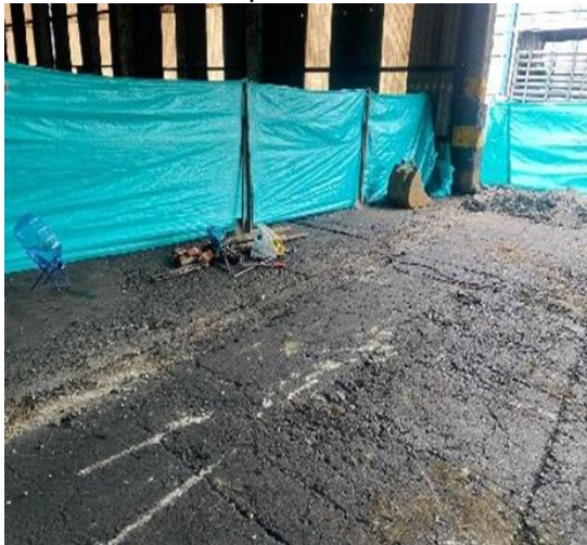
Ilustración 11. Supervisión de instalación de cerramiento
