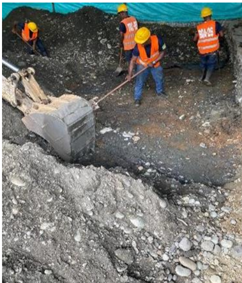
Ilustración 13. Retiro de los residuos de demolición
