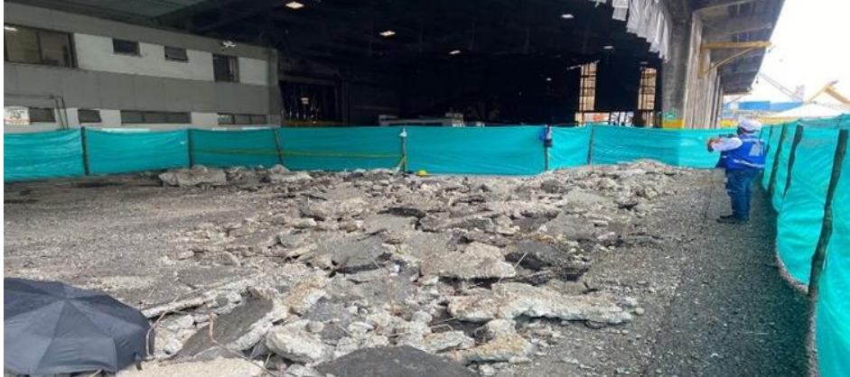
Ilustración 12. Supervisión de demolición de pavimento
