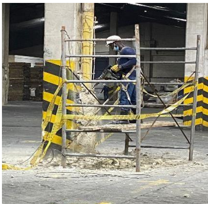
Ilustración 5. Reparación de columna averiada
