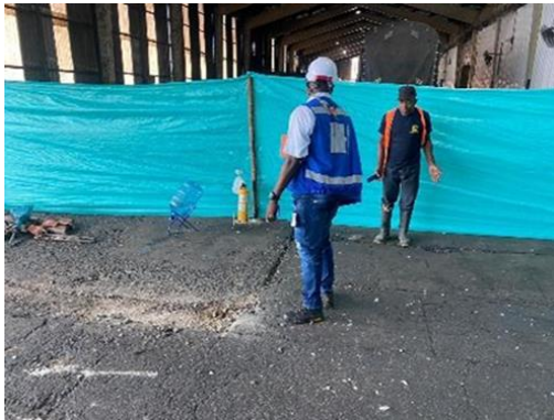
Ilustración 10. Cerramiento provisional de obra
