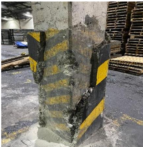
Ilustración 4. Columna Averiada
