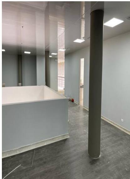
Ilustración 6 Lijado y aplicación de pintura acriltext sobre muros
