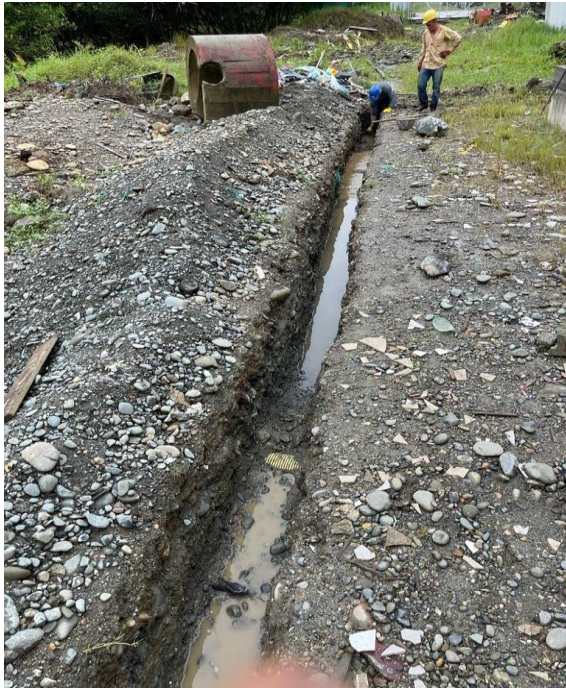
Ilustración 13 Excavación e instalación de la tubería de polietileno de 6" pulgadas para red contraincendios
