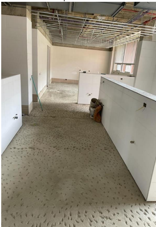
Ilustración 10 Afinado de piso en aula de clase
