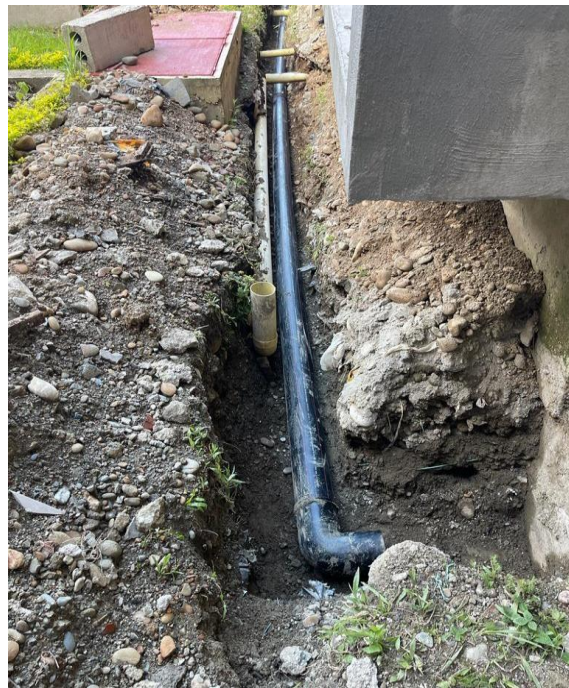
Ilustración 13 Excavación e instalación de la tubería de polietileno de 6" pulgadas para red contraincendios
