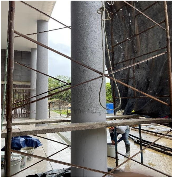
Ilustración 5. Aplicación de graniplast en viga
