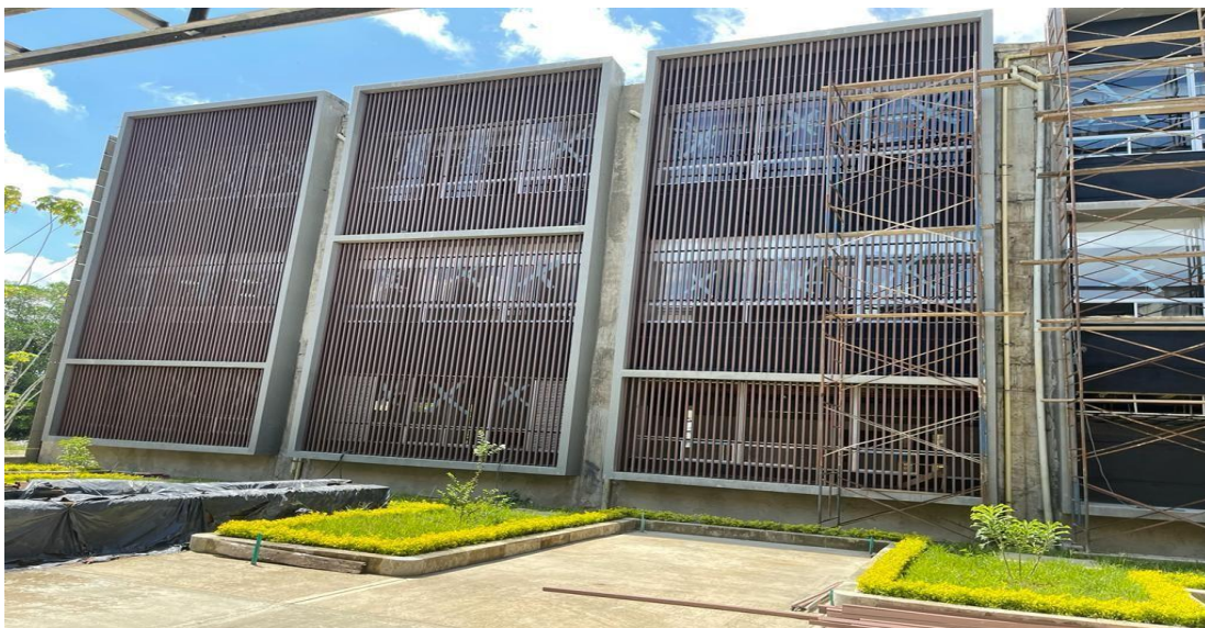
Ilustración 9 Instalación de fachadas y puertas en eco Wood
