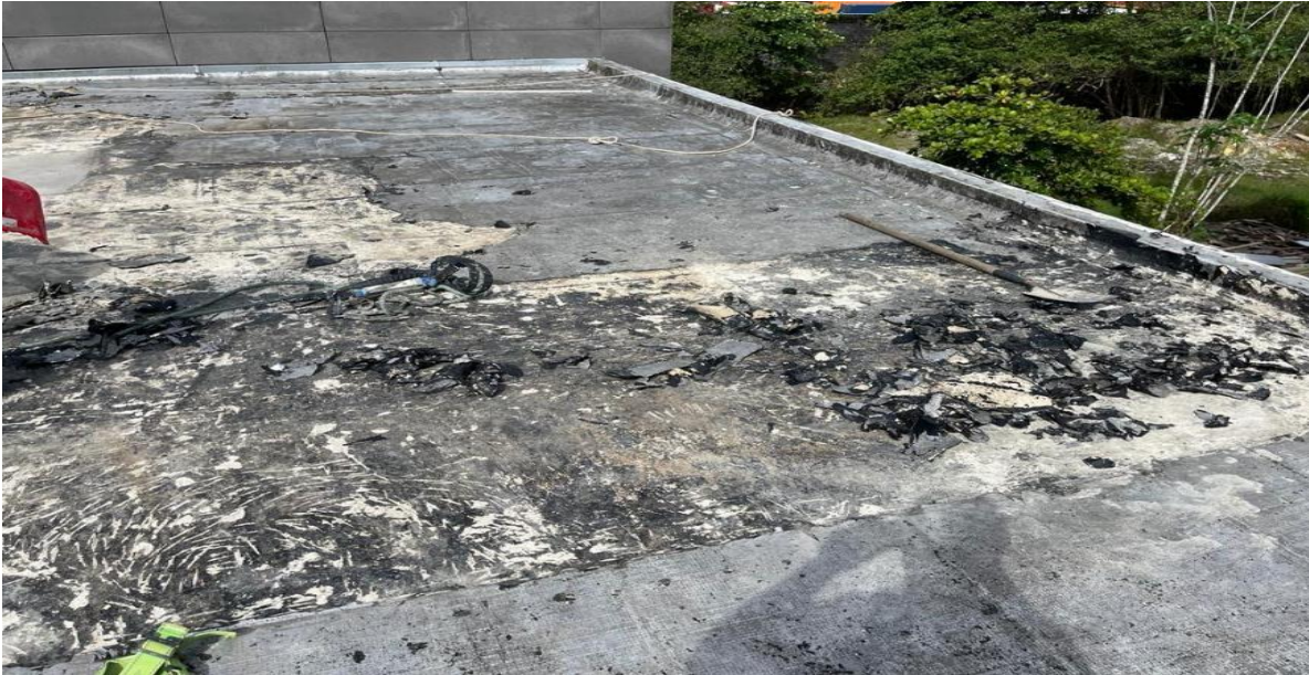
Ilustración 11 Impermeabilización en la placa de cubierta en el Shut de Basuras
