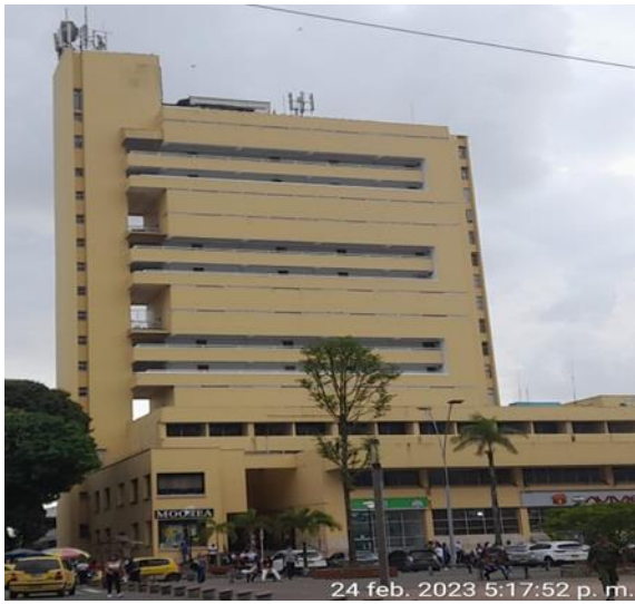
Ilustración 5 EDIFICIO DEL CAFE BUENAVENTURA
