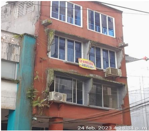
Ilustración 4 EDIFICIO ZONA CENTRICA BUENAVENTURA
